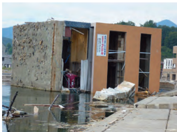
ビルが根こそぎ倒壊 女川
