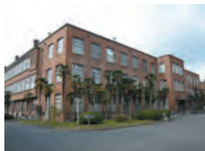
図5 京都高等工芸学校本館(現・本学3号館)
